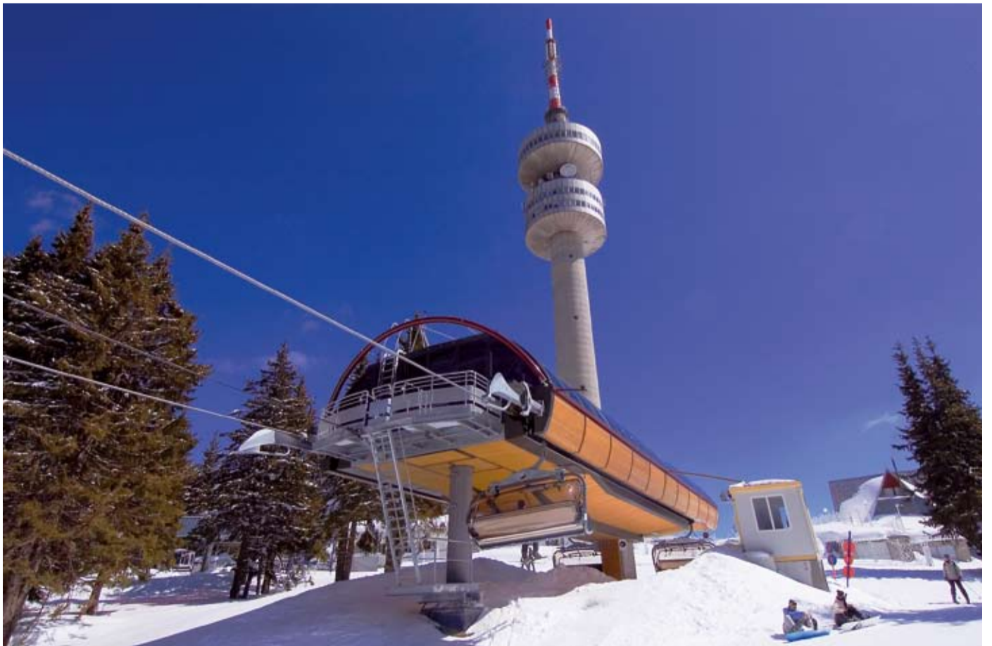
▲ DIE TALSTATION DER MULTIX 6-HAUBENSESELBAHN
