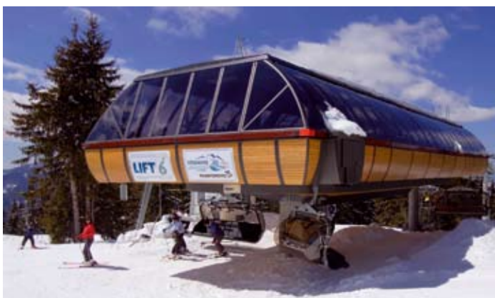
▲ ESTACIÓN DE LLEGADA
