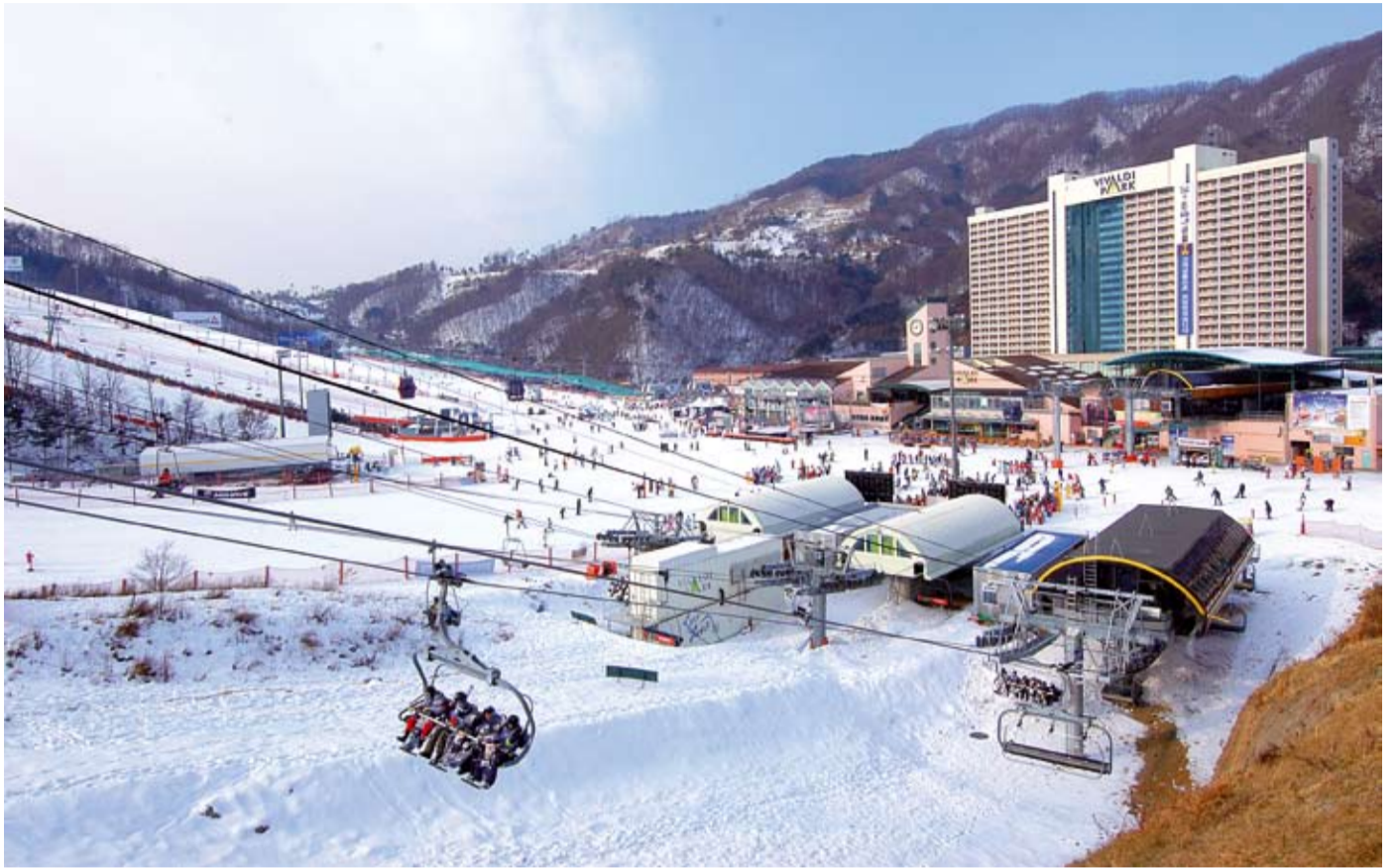
▲ VISTA GENERAL DE LA ESTACIÓN
