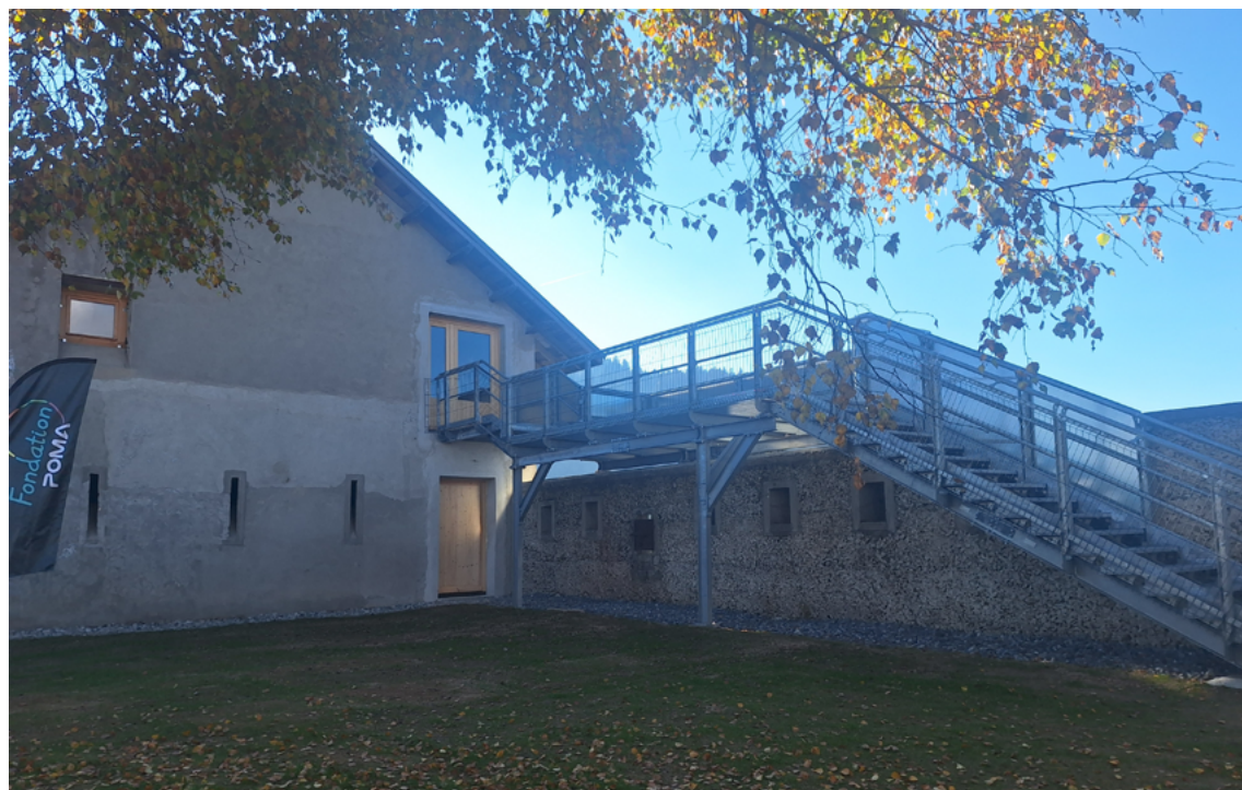
La passerelle, fraîchement installée, lors de la journée d'inauguration en octobre.
